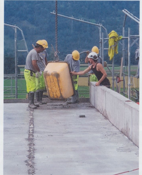
Hier wird am 15. September der letzte Kübel Beton eingebracht. Bild zVg
